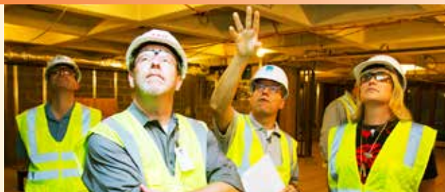
La Subdirectora Gerente Carla Grasso (derecha) inspecciona los avances en la renovación del edificio HQ1.
